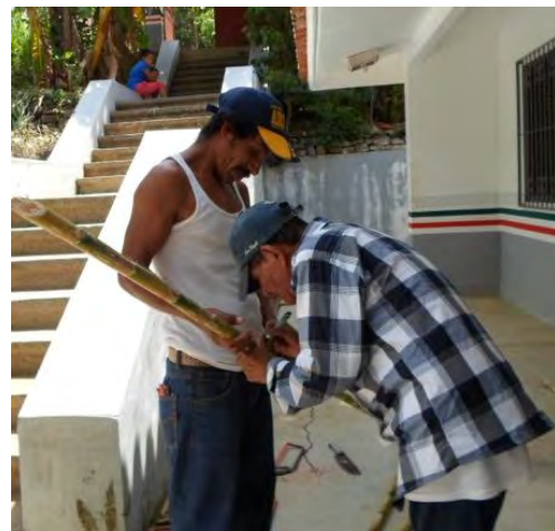
110_Toma de medidas para corte y armado de somé en caña brava.
