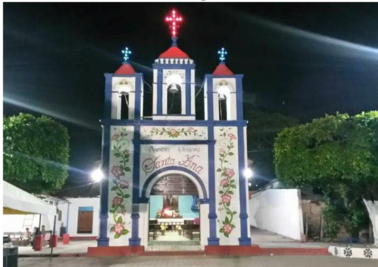
Foto 8. Fachada de la iglesia de Santa Ana
