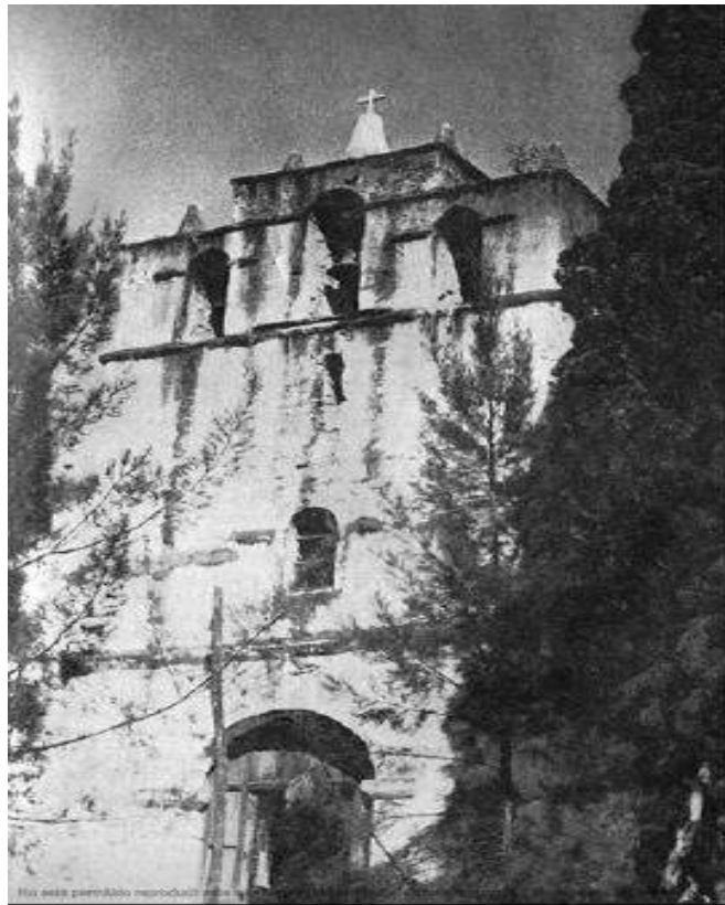
Figura 4: Fachada de la iglesia de San Miguel Arcángel, Pinola
