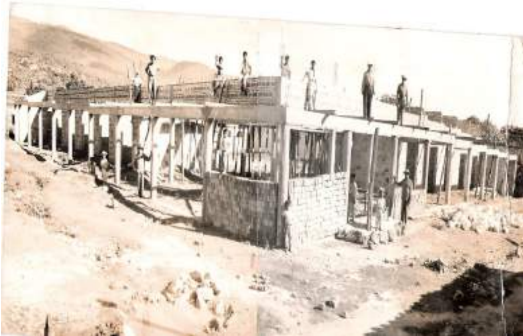
Figura 16: Construcción del Mercado Jorge de la Vega (1950)
