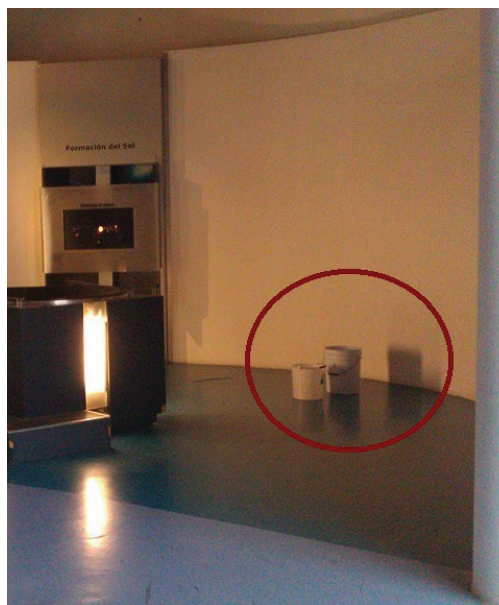
Ilustración 2.12.5 Presencia de dos cubetas para las goteras. Foto tomada por Jesús Pérez López.
